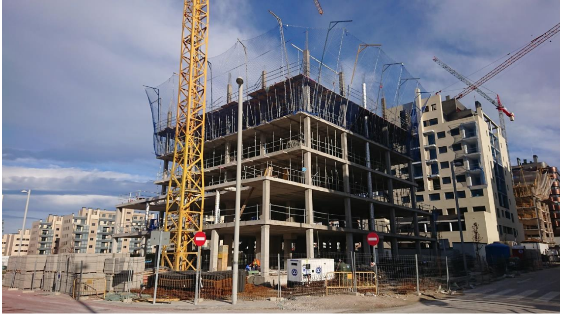
Foto nº 1: Vista general de la obra en ejecución.
